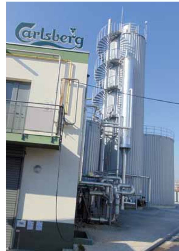
Пречиствателната станция на Carlsberg в Благоевград
